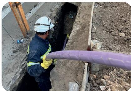
Tras las gestiones del Municipio, Edesur comenzó con la colocación de cables para potenciar la energía eléctrica en Canning. Se instalarán 2.925 metros de tendido subterráneo y, una vez finalizada esta tarea, la empresa se ocupará de la reparación de las veredas y calles afectadas por las obras.
